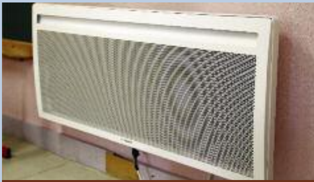
Nouveaux convecteurs à l'école de Taulhac.
