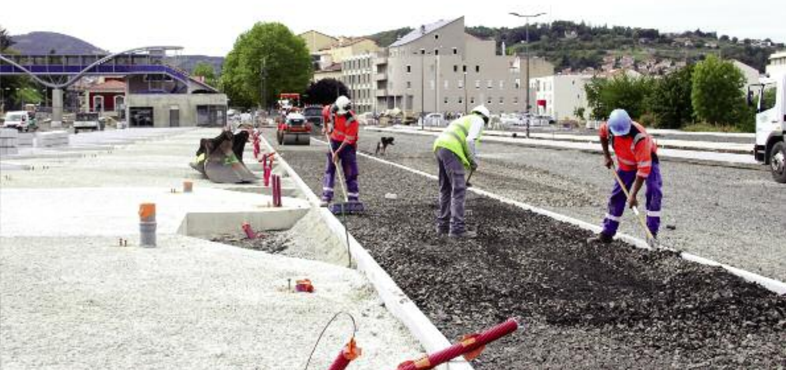
Une dizaine d'entreprises locales sont à pied d'oeuvre. Le projet du Pôle d'Echanges Intermodal sera mis en service en juillet 2016.
