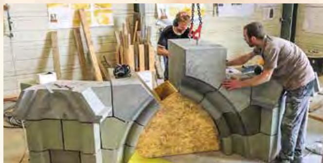
Assemblage "à blanc" en atelier
