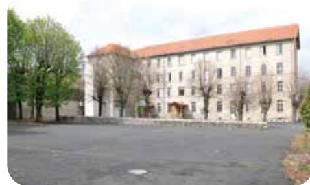
Avant démolition, avril 2012
