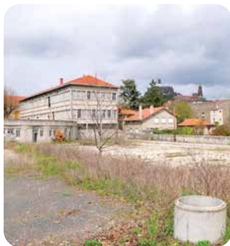
Avant démolition, avril 2012
